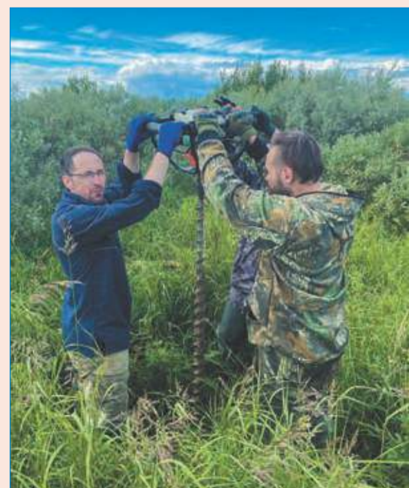
Начальник управления инженерно-геодезических работ М. Н. Николаев, замерщик Е. И. Титов и ведущий геодезист Д. А. Медведев бурят скважину для репера на Кумжинском месторождении
